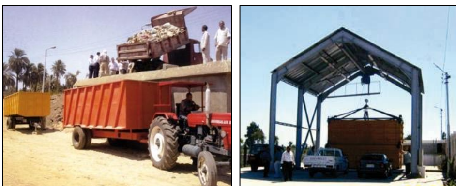
Figura 34 – Exemplo de estações de transferência (adaptado de (Coffey, M; Coad, A., 2010)
