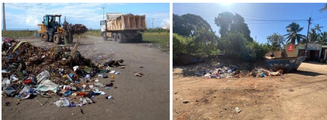
Figura 20 – Remoção de ponto no chão no bairro de Natite com recurso a máquina com pá escavadora (esq.) incluindo efeitos de escavação/erosão (dir.)
