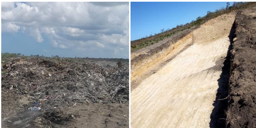
Figura 24 – Acesso na lixeira municipal (esq.) e abertura de trincheira (dir.)
